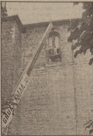
La reparación la está realizando una empresa de Irún. (Foto Kiñu)
