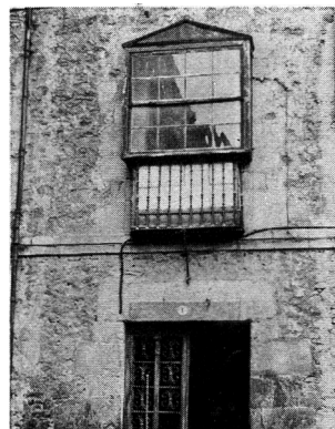
—Mirador construido expresamente para que el Rey Felipe II viera las corridas de toros que se celebraban en la plaza. La corriente de aire, habitual en este lugar, hizo adoptar esta medida.
