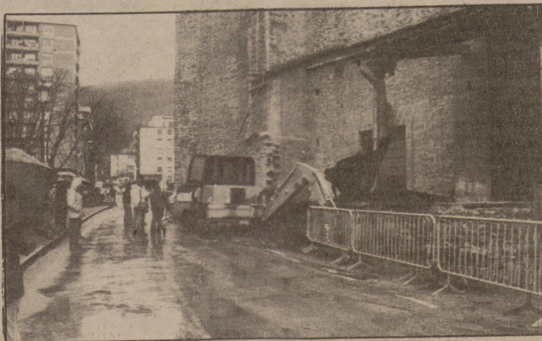
La excavadora fue colocada ayer en el mismo lugar en el que se encontraba el día del derrumbe. (Foto Kiñu).
